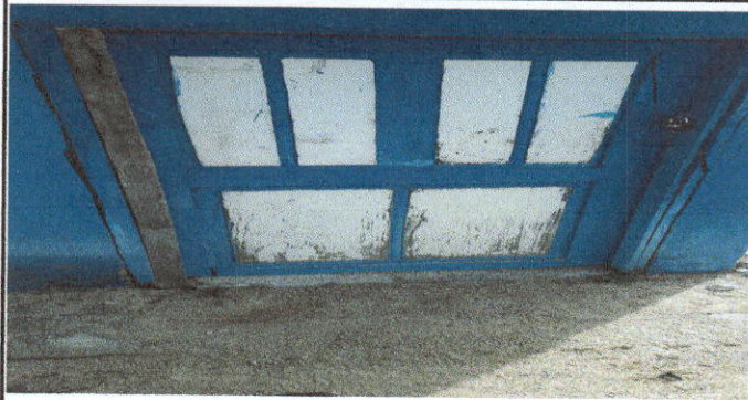
Foto1: Sustitucion de puerta de madera por metal
