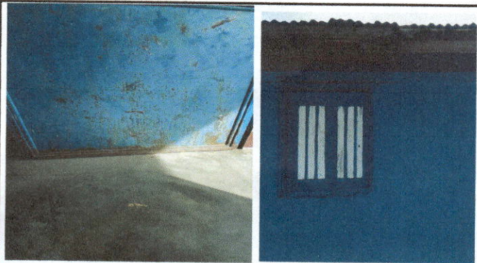
Foto 3: mantenimiento a estructura y sustitucion de ventana de madera por metal mas vidrio
